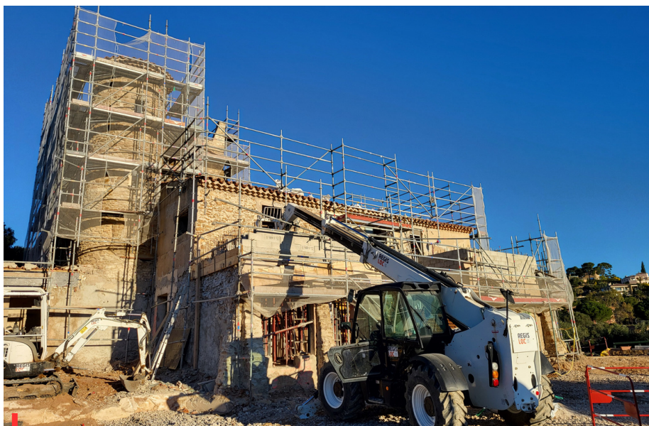
Installée dans une bâtisse historique, la Maison du Parc nécessite d'importants travaux
