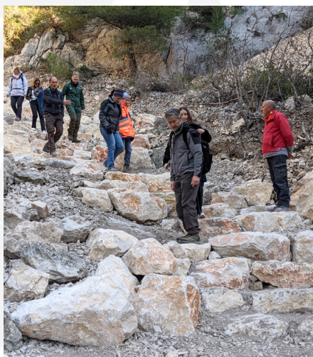
Mars : Réception des travaux sur le sentier du Portalet. La fréquentation est désormais canalisée et les habitats naturels sauvegardés de l'érosion.
