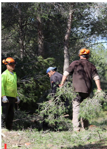
Travaux de débroussaillage sur la route de Sormiou
