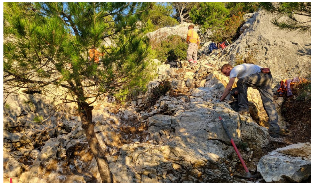
Technique de la pierre sèche, réemploi de matériaux locaux, présence ajustée d'engins de chantier... les travaux sur sentier exécutés en cœur de Parc répondent à des critères environnementaux élevés
