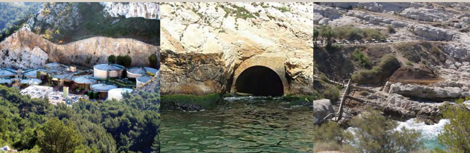
Emissaire de Cortiou et tas de scories issues du passé industriel des Calanques – Lakko Marseille, PNCal, Coloco
